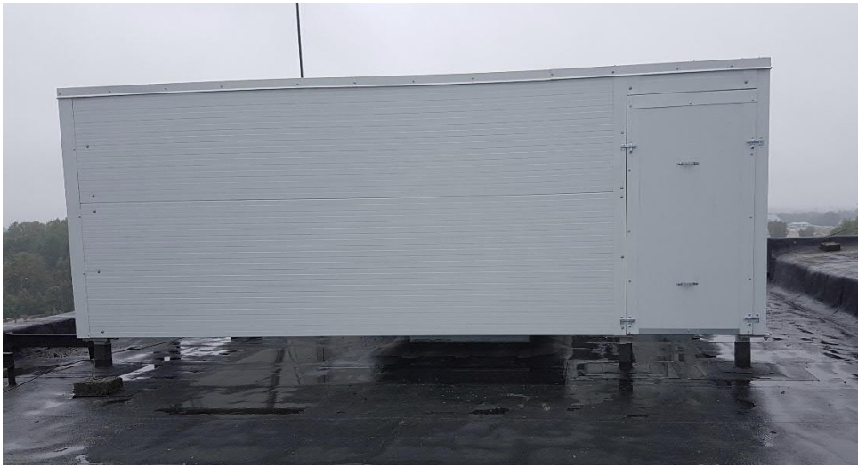
Foto 5. Aspiratsiooniseadmed ja nisuveski koos rajatud 2 m kõrguse müraekraaniga
