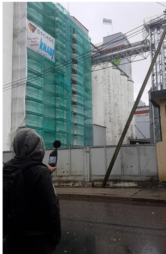
Foto 4. Lembitu tn 10 elamu hoone ees
